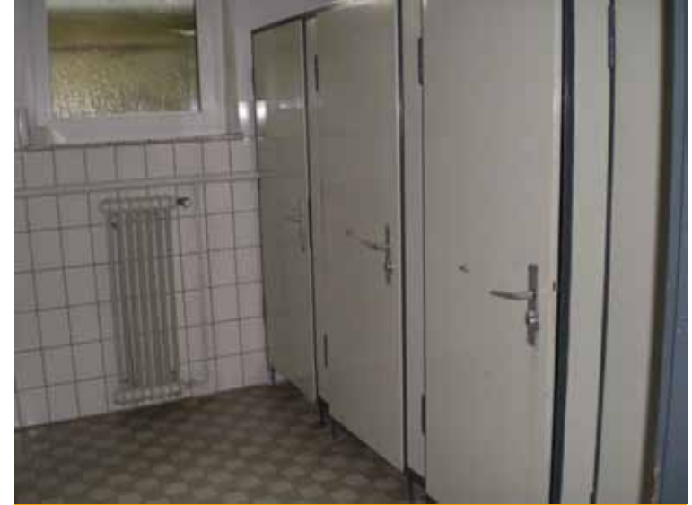
Sanitäranlagen im Dorfgemeinschaftshaus
